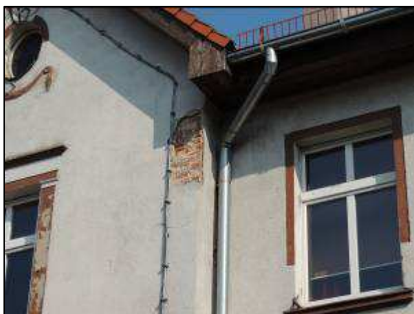
Fot. 6-10. Na zdjęciach widoczne ubytki tynków, powłok malarskich. Zniszczone, skorodowane odwodnienie dachu. Uszkodzenia mechaniczne i biologiczne ścian zewnętrznych budynku.
