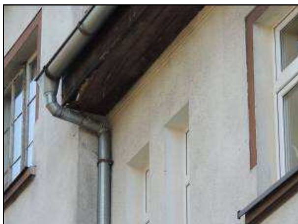
Fot. 6-10. Na zdjęciach widoczne ubytki tynków, powłok malarskich. Zniszczone, skorodowane odwodnienie dachu. Uszkodzenia mechaniczne i biologiczne ścian zewnętrznych budynku.
